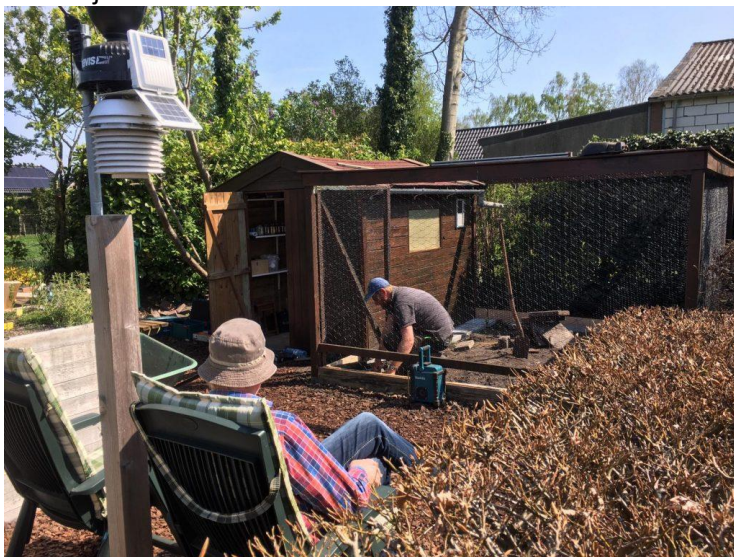
Volière in aanbouw
