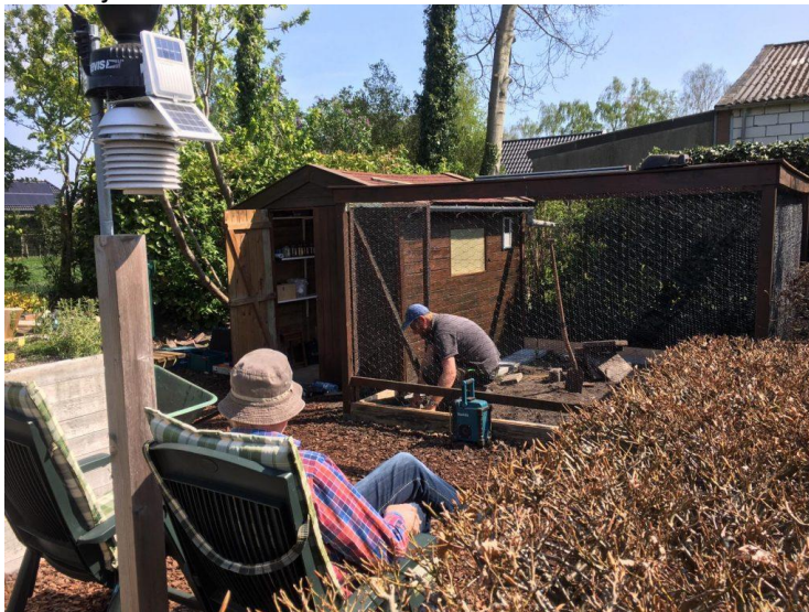
Volière in aanbouw
