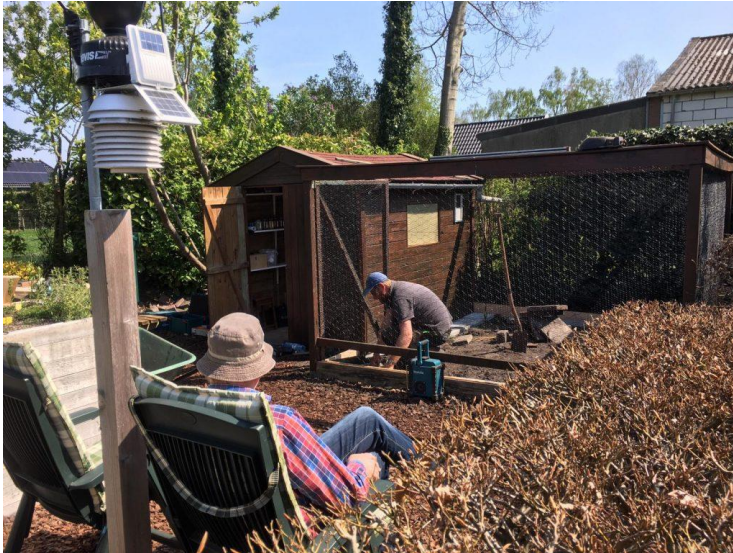
Volière in aanbouw
