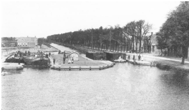
Foto van de Stenenverlaat vlak nadat de 2 e sluis (rechts) in gebruik werd genomen. In de 2 e sluis worden 2 afgeladen turfschepen geschut. (Foto Groninger Archieven)
