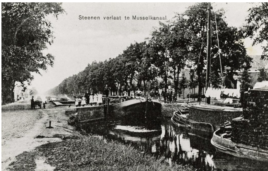
Foto uit 1913 van de Stenen Verlaat of 5 e Verlaat tussen de Sluisstraat en Sluis-kade, gebouwd in 1851. In 1917 kwam er een 2 e sluis. Op de voorgrond liggen 2 turfschepen te wachten om te worden geschut. (Foto Groninger Archieven).
