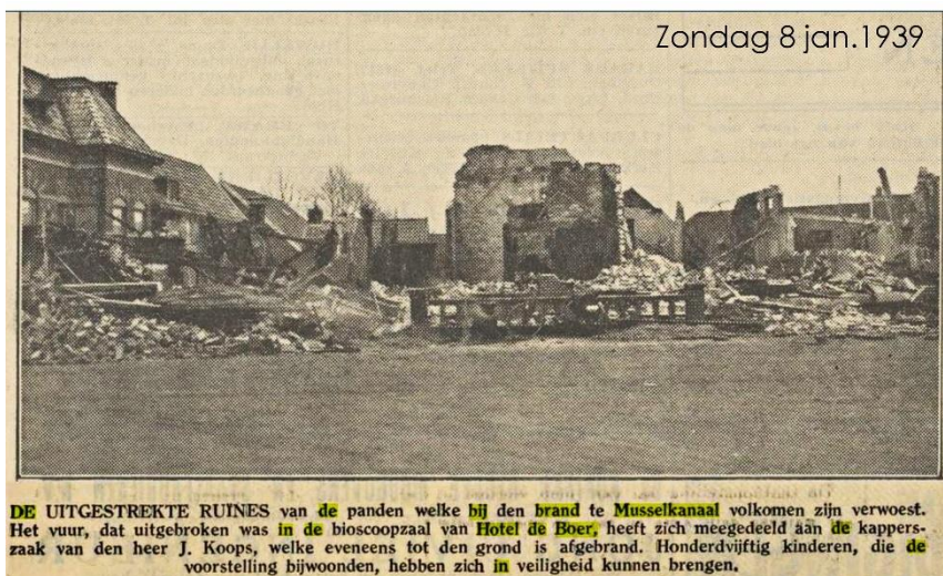
Het door brand verwoeste Hotel de Boer, links op de foto Hotel Schot
